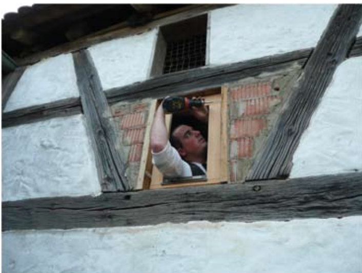
Roger der Wandergeselle beim Fenstereinbau
